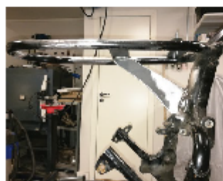
Støtte for seteramma ble et 10 mm flattjern sløpt i en passende form. Seteramma bak støtten ble forsterket med et innvendig rør.
